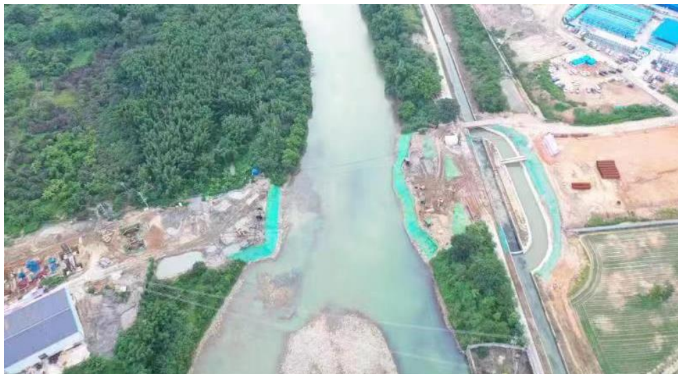
图 2-19 桥梁施工现场航拍照片
