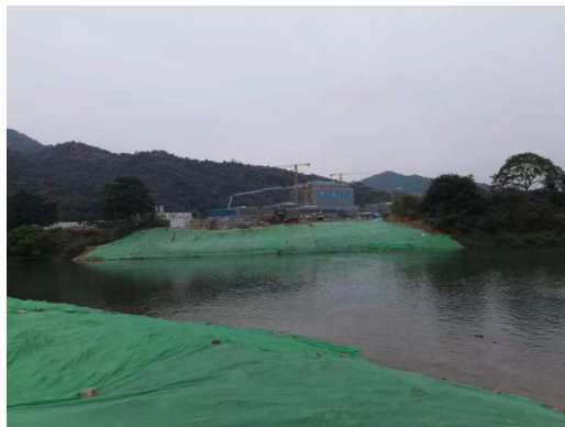
施工现场铺设防尘网
