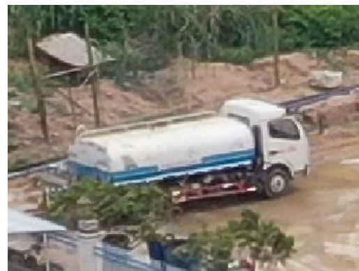
施工现场洒水车
