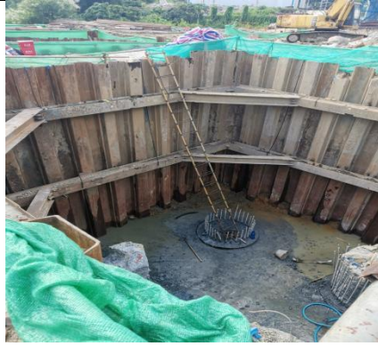
桥梁施工期围堰照片
