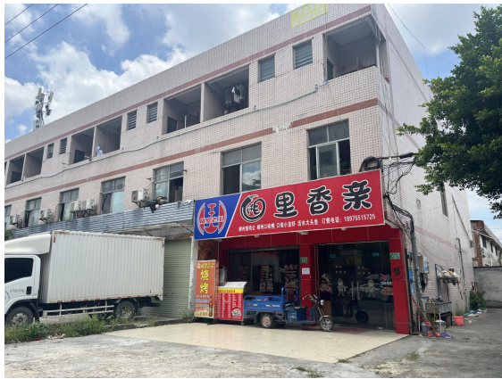
项目南面：广州自豪机械制造有限公司
