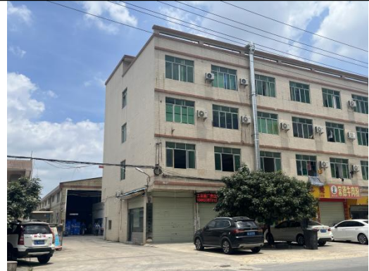
项目北面：广州宏盛机械有限公司
