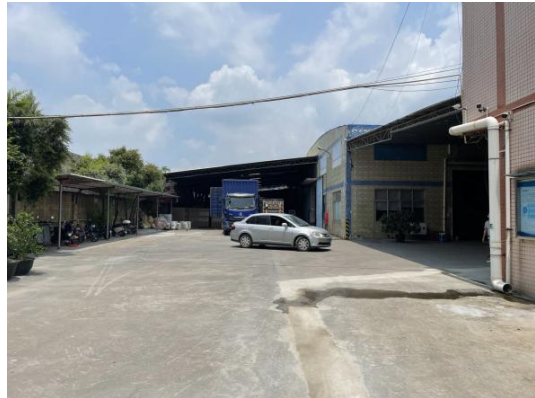
项目现状：厂门入口处
