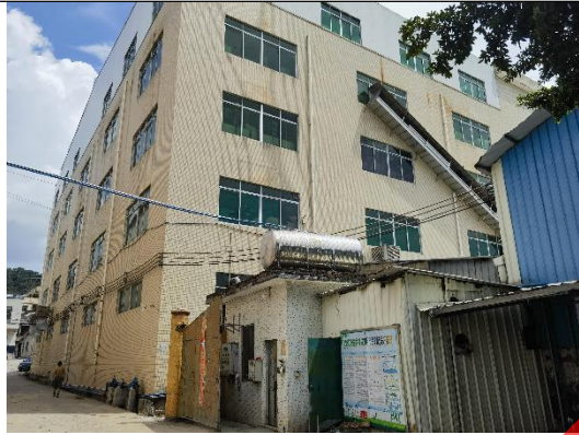
项目东北面-工业厂房
