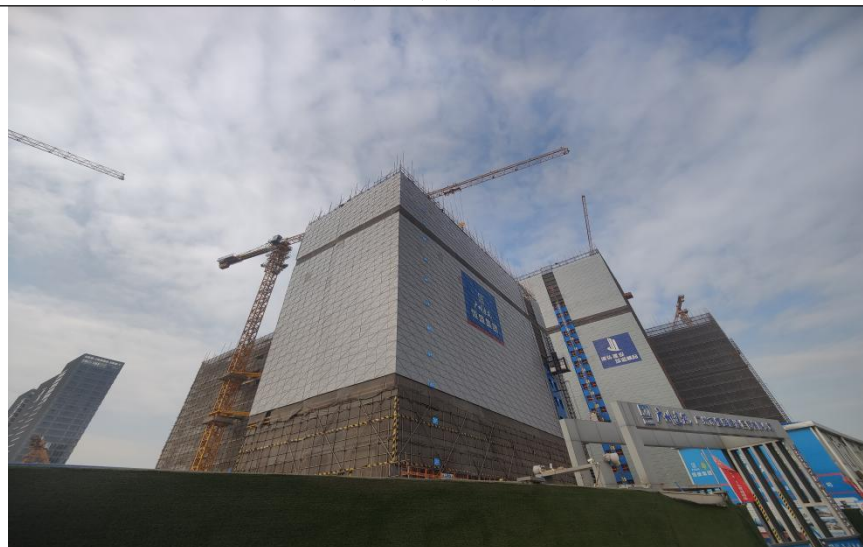
北面--建研创新大厦（在建）
