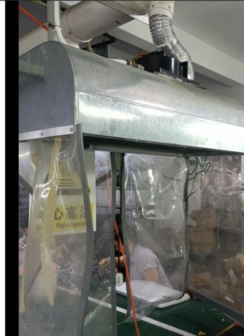
现有项目实际半自动锡炉废气收集情况
