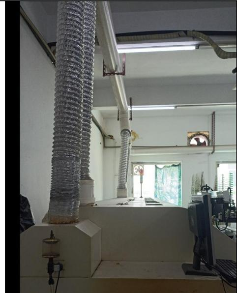
现有项目实际回流焊废气收集情况
