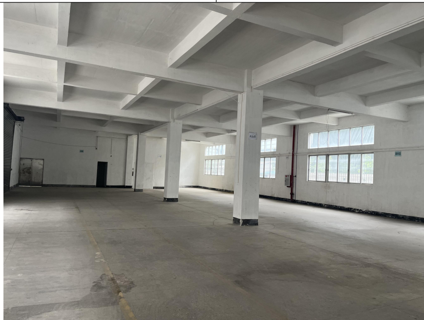
项目所在建筑 (园区 A8 栋厂房)
