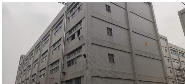
项目南面—园区 A7 栋厂房 (距本项目厂界 11m)
