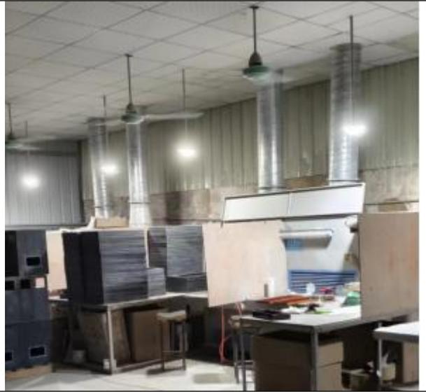
打磨废气处理设施-脉冲滤筒除尘器（TA003）处理后由15米高排气筒（DA003）排放
