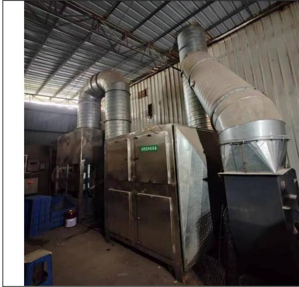
调漆、喷漆、自然晾干、清洗、擦光废气处理设施-“水喷淋（顶部自带除雾板）+活性炭吸附”（TA001）
