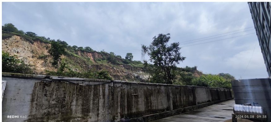
项目西北面：空地
