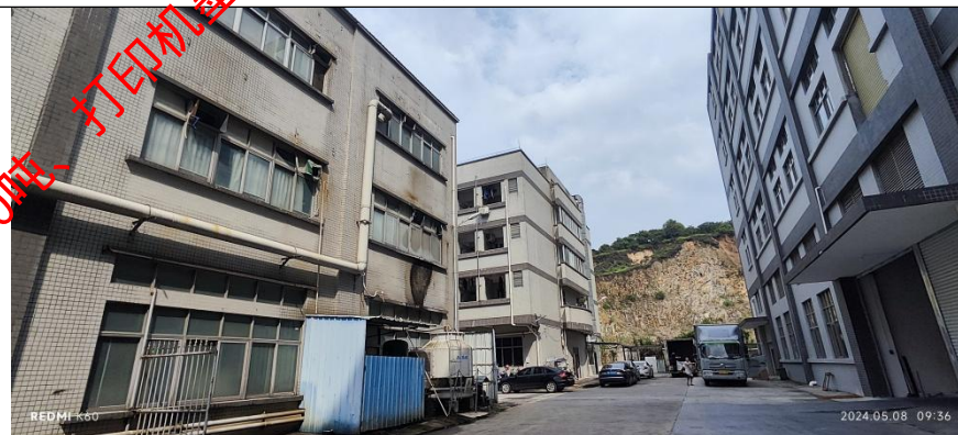
项目西南面：园区其他厂房
