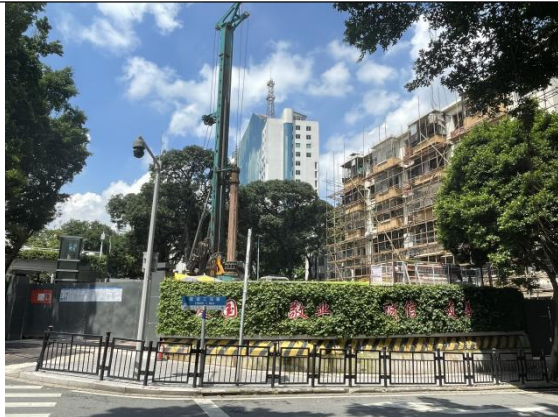
西面 拆迁施工场地
