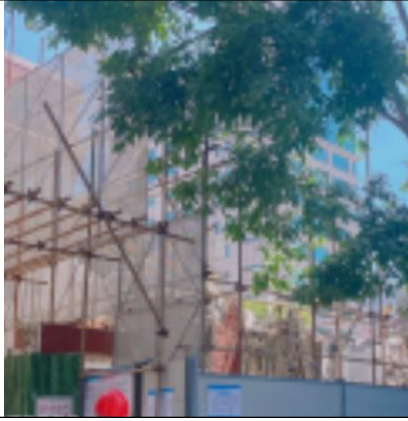
东面 拆迁施工场地
