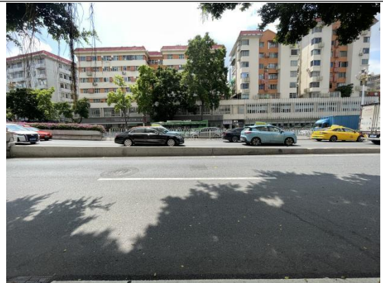
西面 建设三马路 3 号居民楼
