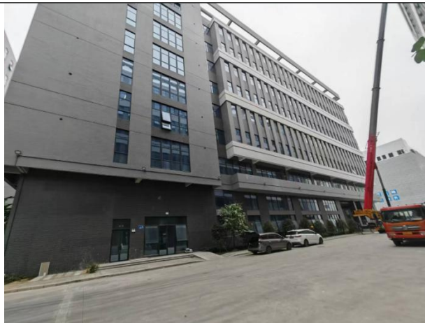
项目西面-空厂房
