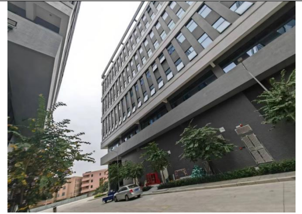
项目南面-空厂房
