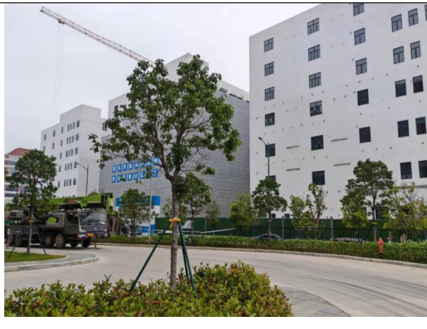
项目北面-工业厂房
