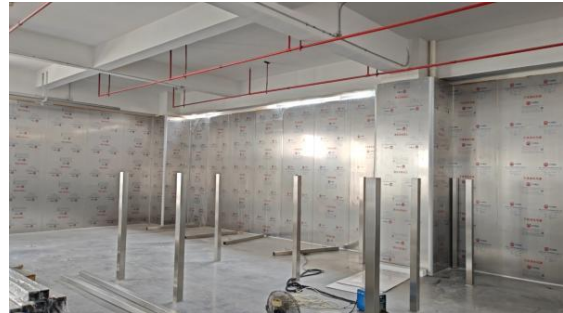
项目车间现状
