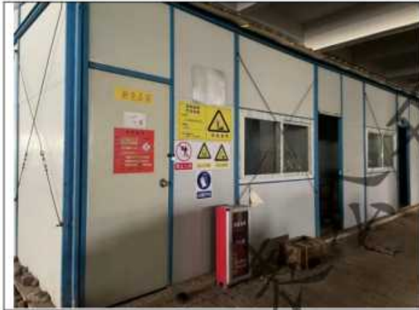
本企业危废暂存间
