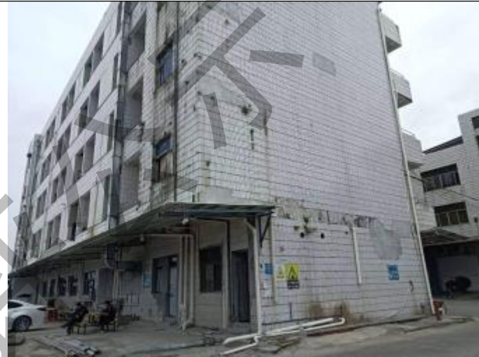
项目南面-园区宿舍楼
