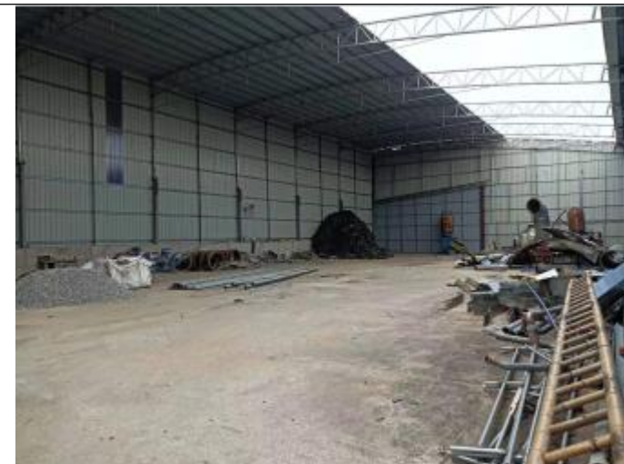
项目北面-空厂房
