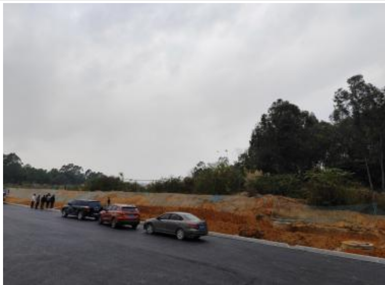
项目西面（空地）
