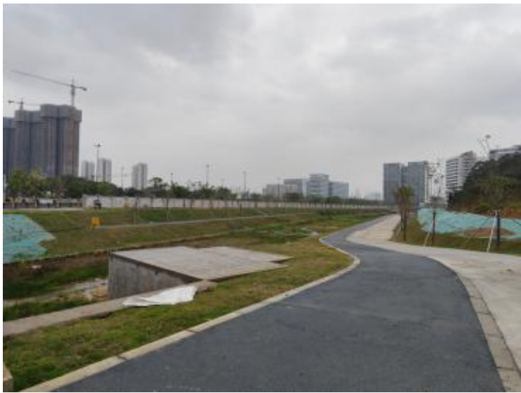
项目东面（内河涌及创新大道）
