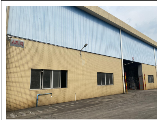
厂区东侧-厂区内 A 厂房
