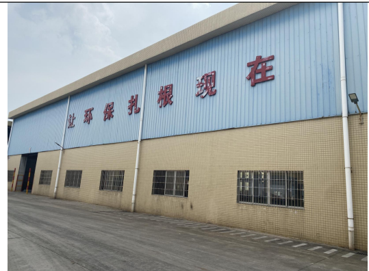
厂区北侧-厂区内 D 厂房
