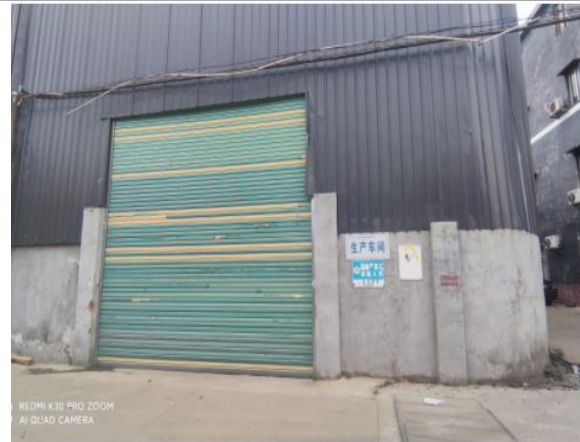
项目西面-空厂房
