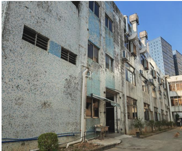
北侧 5m 广州锋明信息科技有限公司 (2 栋)
