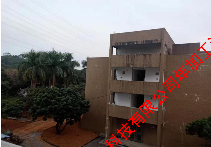
项目东面：永祥文化产业园
