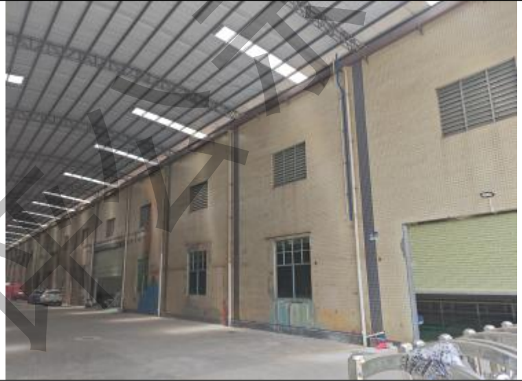
项目北面-建材厂
