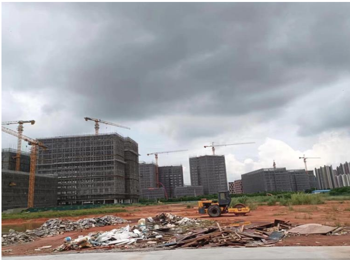
西面广州众智材料科技有限公司在建厂房
