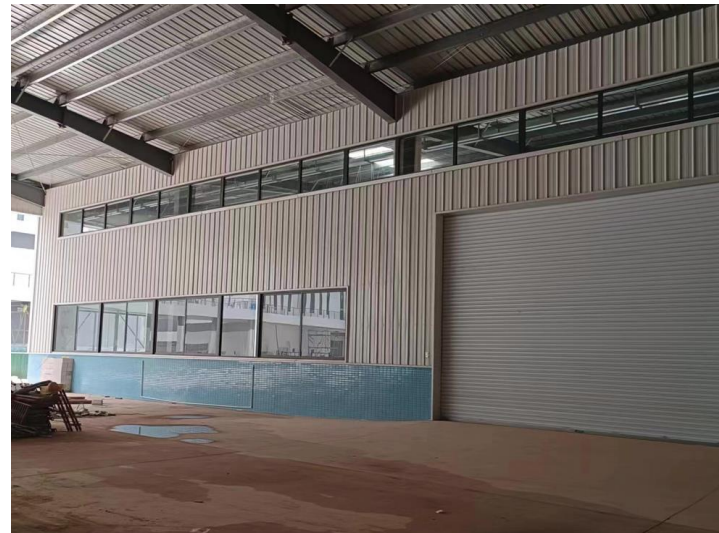
北面广州众智材料科技有限公司在建厂房
