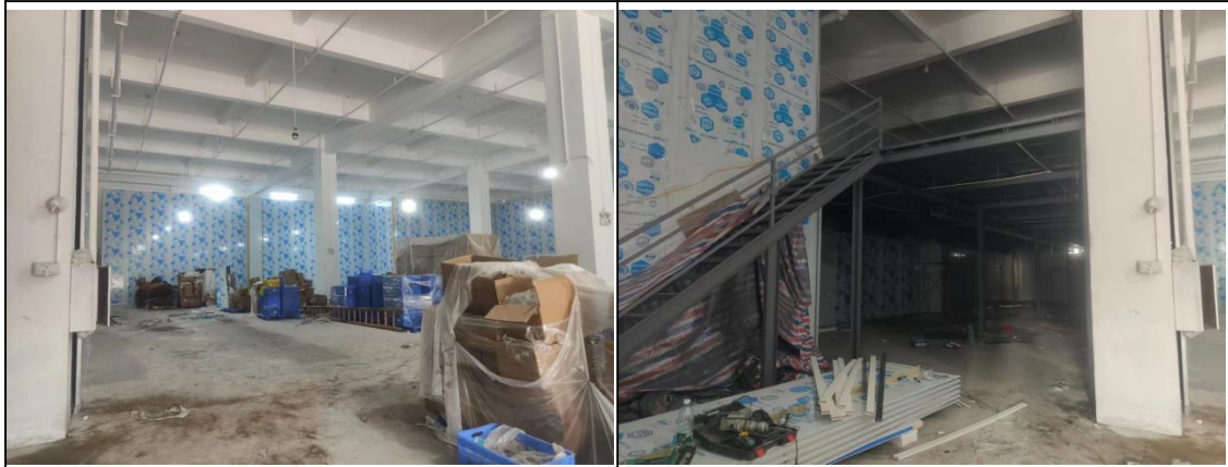
建设项目车间现状
