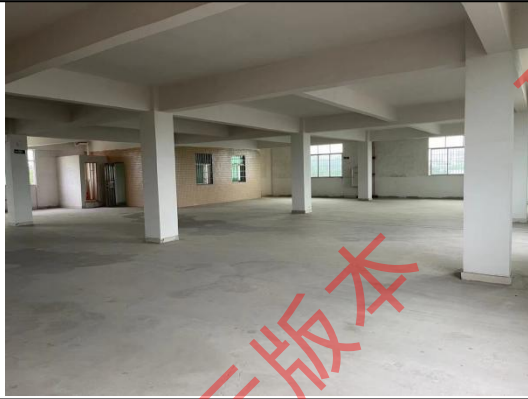
项目厂房内部现状
