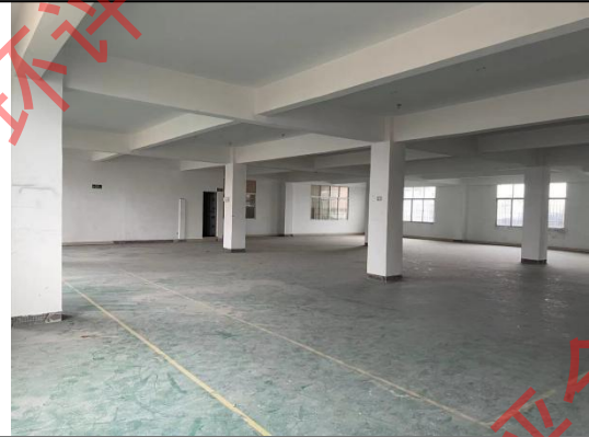
项目厂房内部现状
