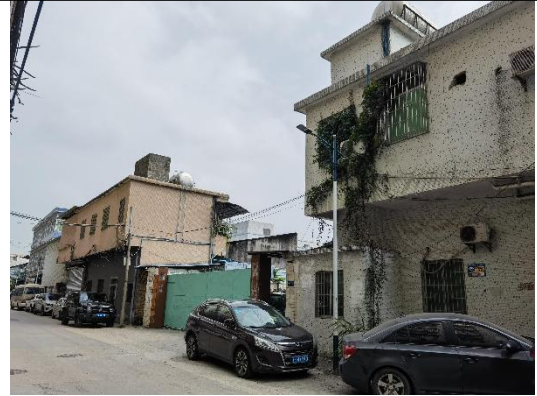
本扩建项目东面-工业厂房
