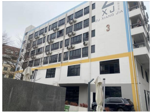
西面：中创汇-大石云核产业园区 3 栋
