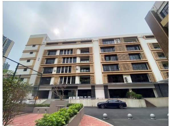
南面：中创汇-大石云核产业园区 2 栋
