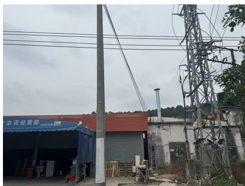
项目西北面—广州标识标牌生产基地
