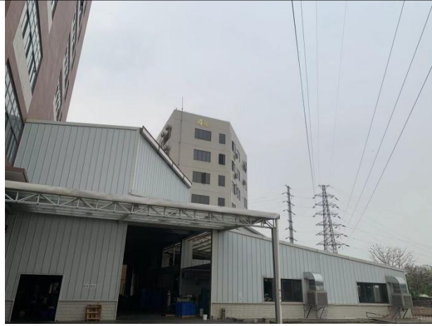
项目东侧-光铭科技园其他厂房
