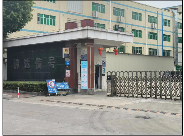
本迁扩建项目南侧-广州市佛达信号设备有限公司
