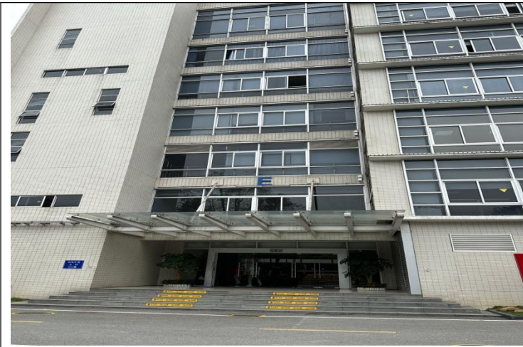
项目东面-园区 E 栋
