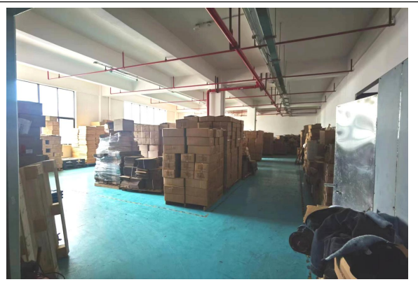
新增车间现状（仓库）
