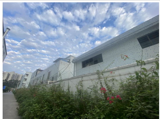
项目南面—欧若拉电子厂
