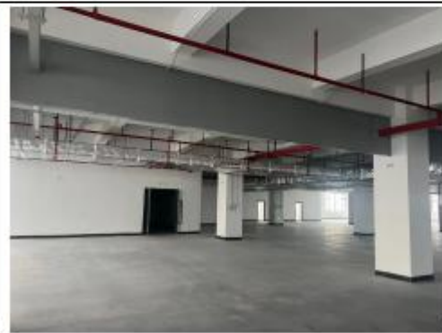
项目内部现状图
