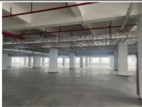
项目内部现状图
