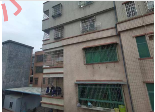
项目南面-朝亮南路居民楼
