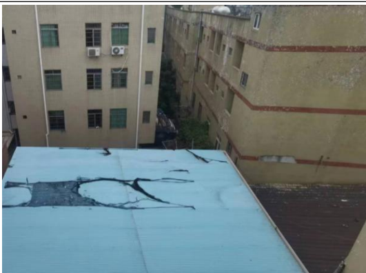
项目西面-仓库
