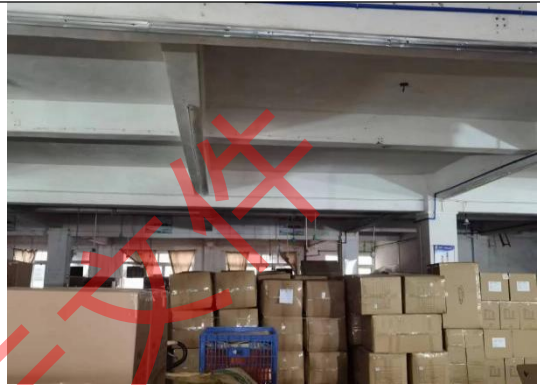
项目 3 楼车间现状
