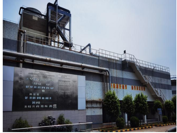
南面（互太（番禺）纺织印染有限公司污水处理站三期工程）
