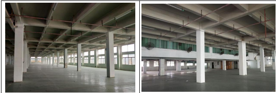
建设项目车间现状
