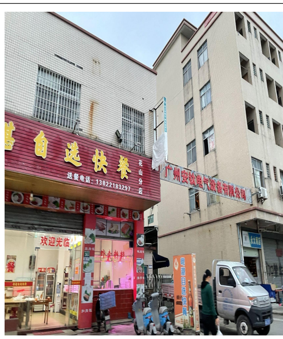
东面（广州安钦电气设备有限公司）
