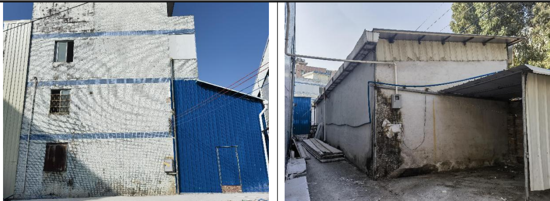
项目南面-工业厂房
