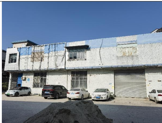
项目西面-工业仓库
