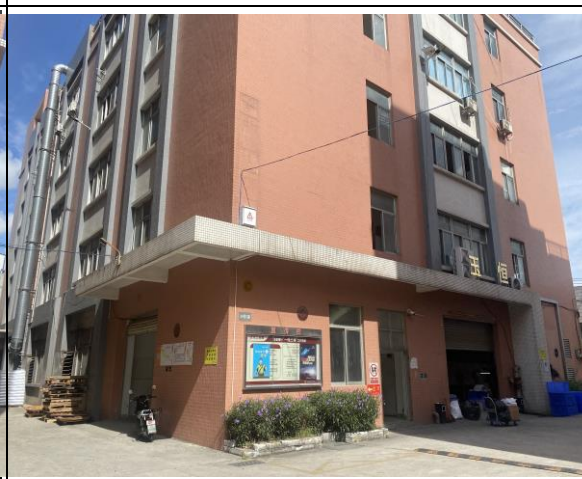
北面：正大工业园 C 栋厂房
