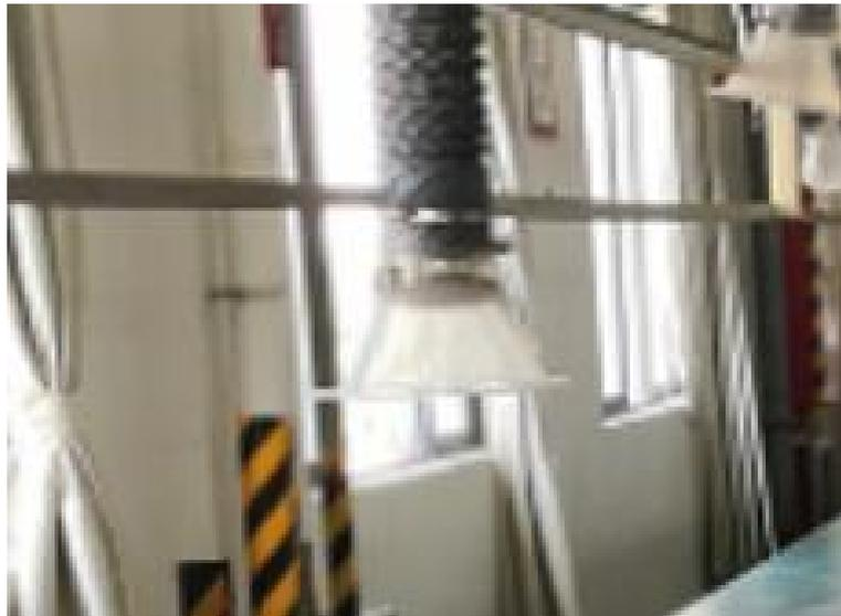
参考《简明通风设计手册》（孙一坚主编）中国建筑工业出版社，第五章第二节局部排风罩的设计计算，上吸式排风罩的排风量 Q 可按下式进行计算
