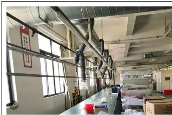
电烙铁焊接生产线集气罩
