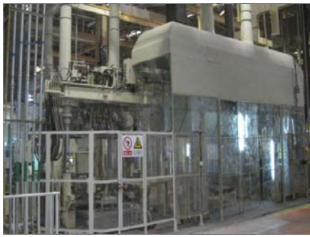
改善前：缸盖取件大部分围蔽
