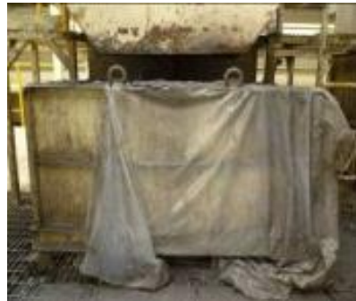
改善漆渣收集装置
