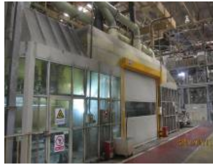
改善后：缸盖取件处整体围蔽
